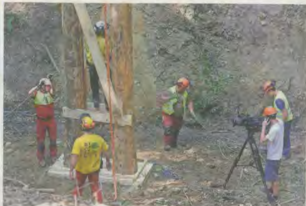
Spektakuläre Montage der Hängebrücken-Stützen gestern in Arisdorf: Der Helikopter flog die Stützen vor Ort, wo sie Förster und Gehilfen montierten. FOTOS: ARSL JAHNHOY
