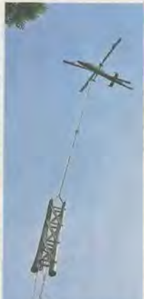
Spektakuläre Montage der Hängebrücken-Stützen gestern in Arisdorf: Der Helikopter flog die Stützen vor Ort, wo sie Förster und Gehilfen montierten. FOTOS: ARSL JAHNHOY
